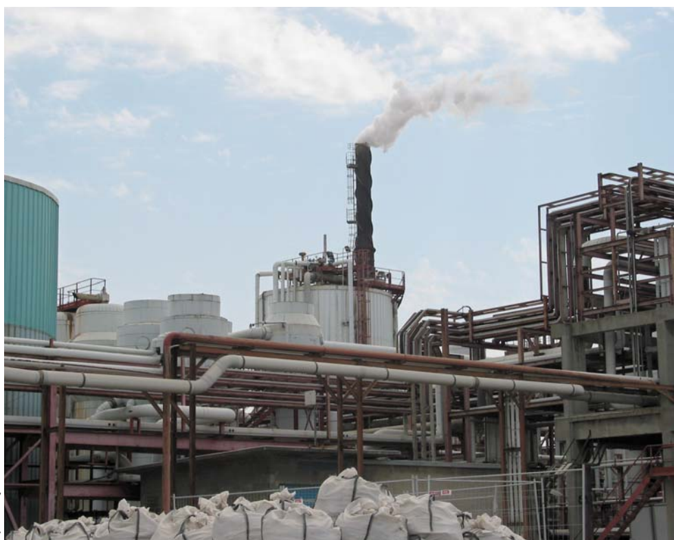
Papeterie TEMBEC à Tarascon dans les Bouches-du-Rhône
