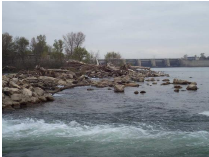
Figure 5 : Déplacement de blocs d'enrochement à l'aval du seuil (CNR - 2016)
