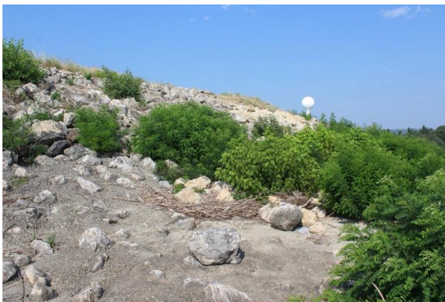
Figure 25 : Enrochements avec développement d'arbustes en rive droite du seuil (ACME – 2017)
