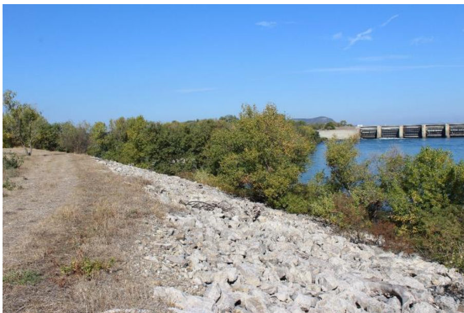
Figure 24 : Enrochements avec bande boisée en pied (ACME – 2017)
