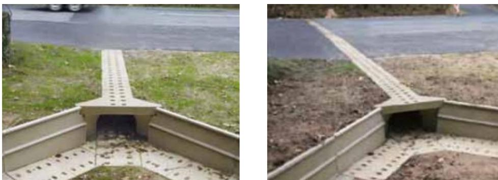
Compensation Cistude - Passages busés « Crapauduc » de la société ACO, fermé enterré sous la chaussée (à gauche) et ouvert (à droite).
