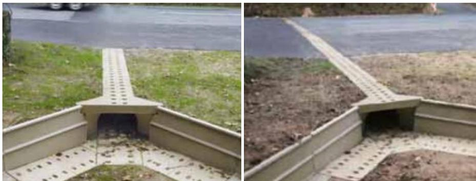
Figure 30 : Compensation Cistude - Passage busé "Crapauduc" de la société ACO, fermé enterré sous la chaussée (à g.) et ouvert (à d.)
