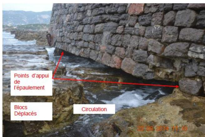
Affouillement et défaut d'appui sur l'extrémité Nord de l'épaulement
