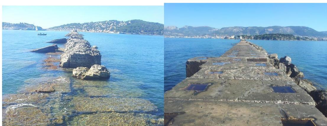
**Figure 4 - Illustrations des différentes parties du corps de la jetée : à droite les zones de blocs béton et à gauche les zones dégradées de blocs moellons (Source CREOCEAN 2013)**
