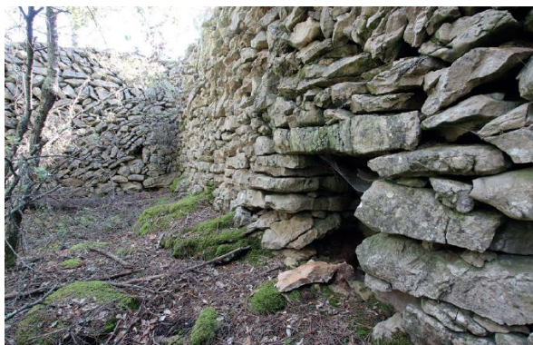
Cabane en pierres sèches en ruine à restaurer et à aménager en faveur des chauves-souris, au sud-est du projet sur la commune d'Aups
