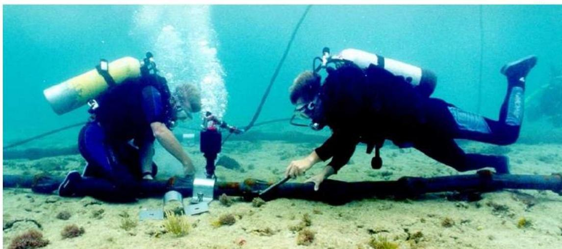
Image 1 : illustration d'une pose de canalisation
