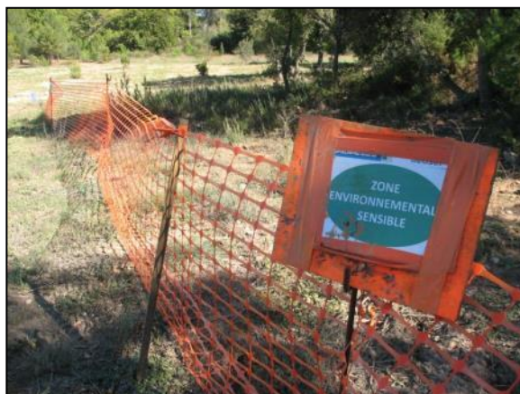
Matérialisation physique de limites de chantier
