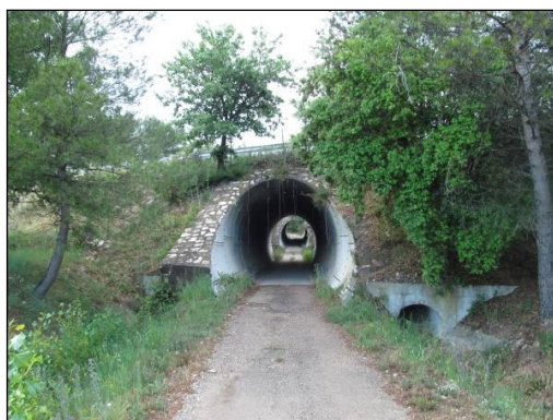
Tunnel sous autoroute présent entre Cambarette Nord et Cambarette Sud : axe de transit pour le cortège chiroptérologique local
