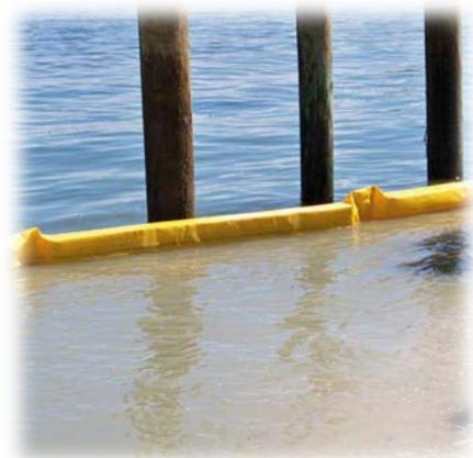
**Exemple de mise en œuvre d'un barrage de confinement retenant les sédiments en suspension**
