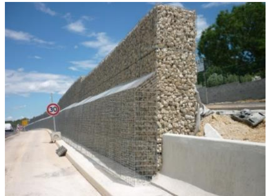
Ecran en gabions
