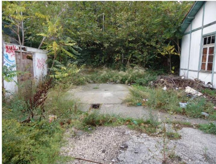
**Photographie 18** : Dalle béton affaissée en son centre entre bâtiment B4 et B5 (Z3, vue direction Sud)
