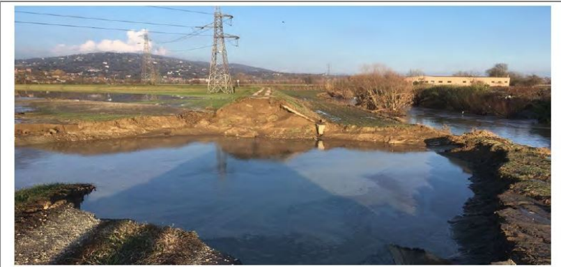
Moncalieri (TO) 25 Novembre 2016: rottura arginale in corrispondenza del Torrente Chisola in prossimità della confluenza col Fiume Po (foto di Fabio Luino, CNR IRPI)
