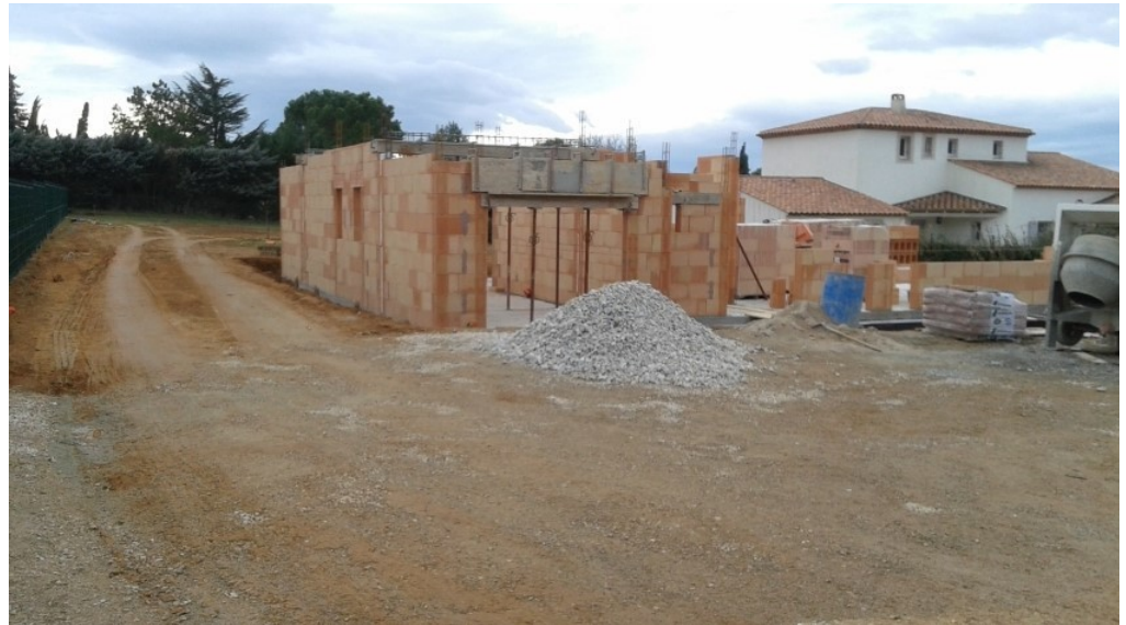
Niveau de la maison plus bas que le terrain alentour – Photo Cerema
