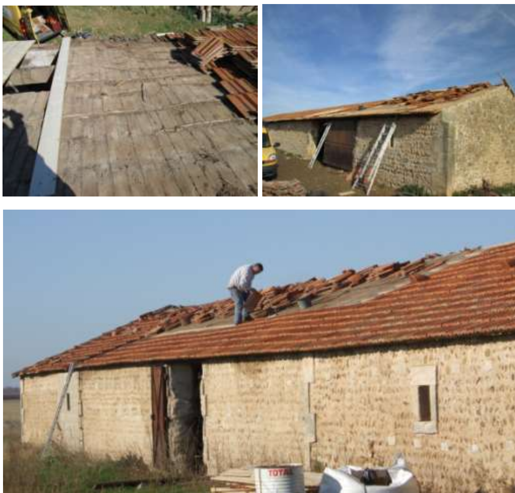
Figure 18 : Travaux de réfection de la bergerie de Peu de Meau suite au vol des tuiles traditionnelles sur les versants nord et sud du bâtiment (en haut), sur la bergerie de Coucou (au milieu) et celle de Calissane (en bas).
