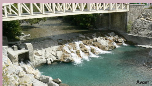
Ouvrage sur le Buech - Les Savoyons (Hautes-Alpes)
