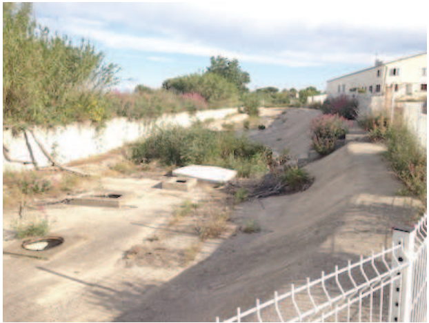
Bassin de rétention bétonné
