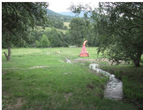
Aperçu du ruisseau des Baumes, en aval du passage busé
