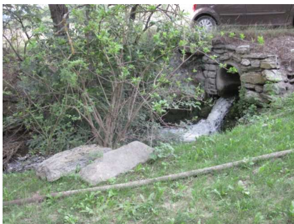
Passage busé au niveau du ruisseau des Baumes
