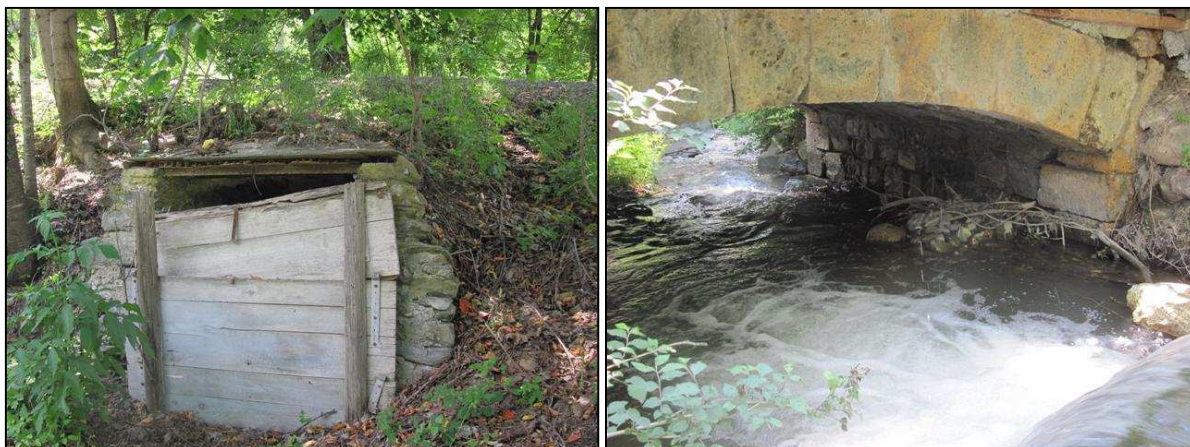
Tunnel souterrain et pont en pierre, potentiellement favorables aux chiroptères
