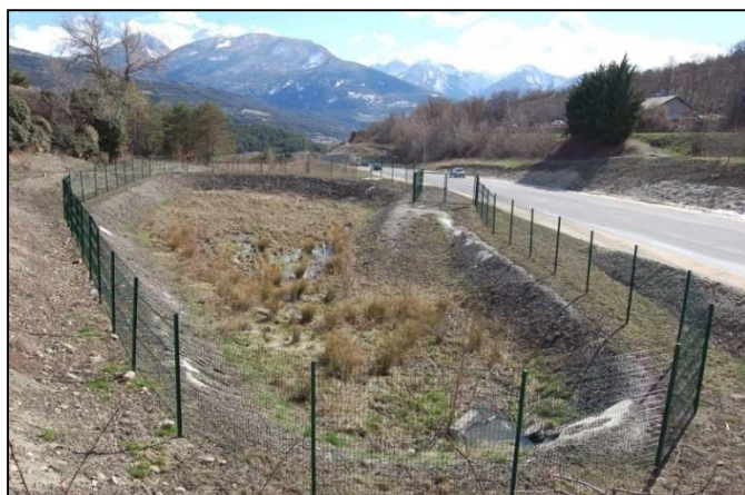
Bassin de rétention en bordure de la rocade d'Embrun (à gauche) et fossé en eau avec pont de Grenouille rousse (à droite)
