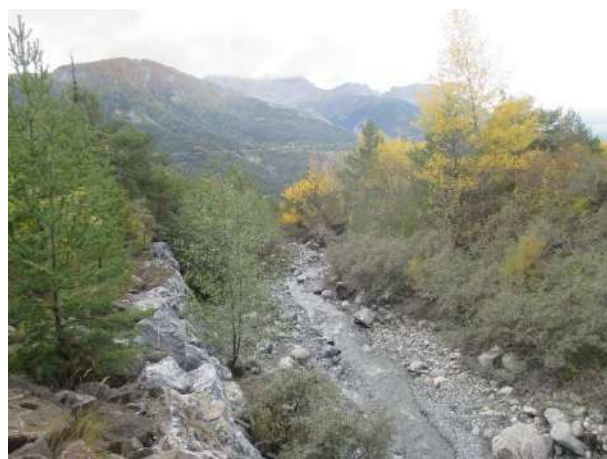
Figure 21 : protection de berge en rive gauche du Riou Bourdoux
