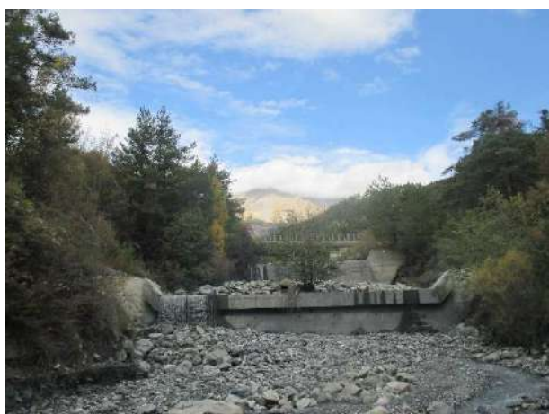
Figure 19 : pont D609 et seuils de stabilisation
