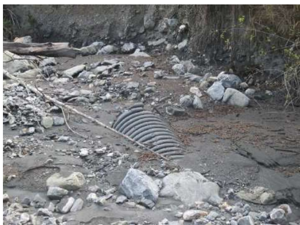
Figure 26 : déchet, passage de chantier dégradé suite à la crue issu de la crue
