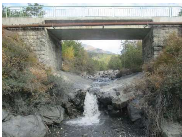
Figure 24 : radier du pont D9
