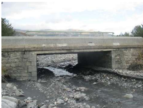
Figure 28 : RD900 – ouvrage hydraulique
