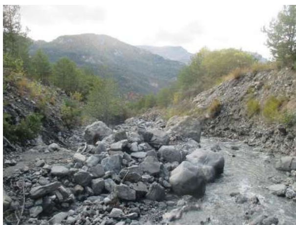
Figure 25 : Riou Bourdoux en aval immédiat du pont D9
