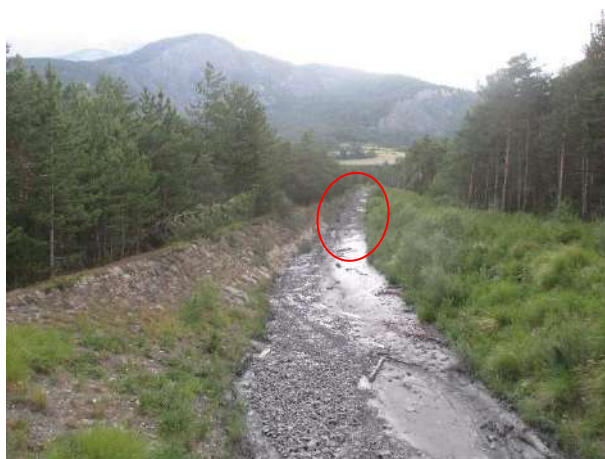
Figure 30 : chenal du torrent de Peissier
