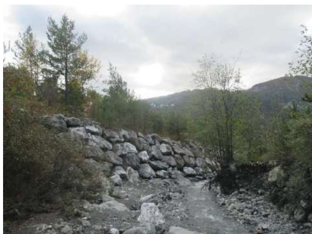
Figure 20 : protection de berge en rive gauche du Riou Bourdoux
