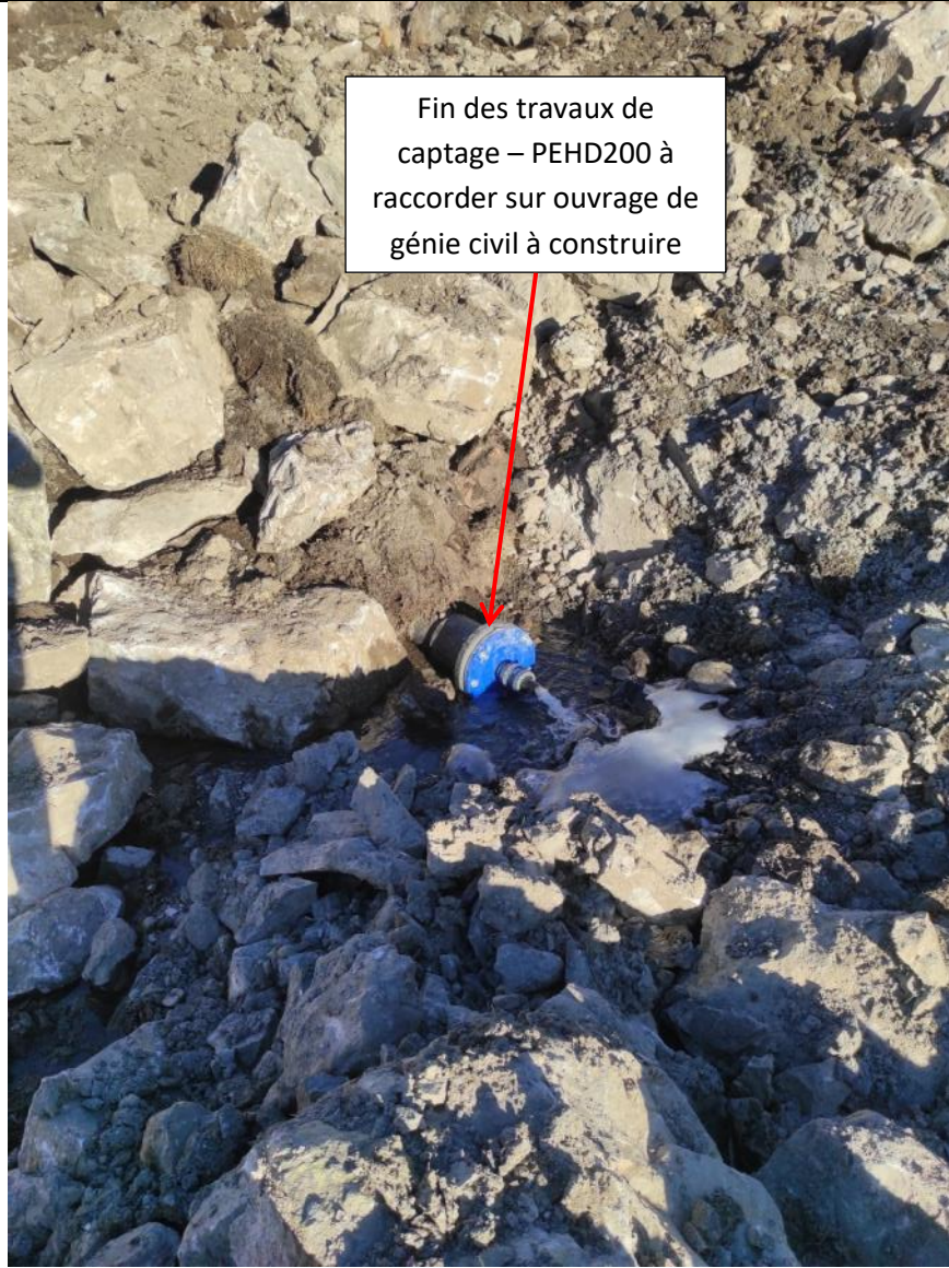
Figure 2 : raccordement de l'ouvrage génie civil (23/11/2020)
