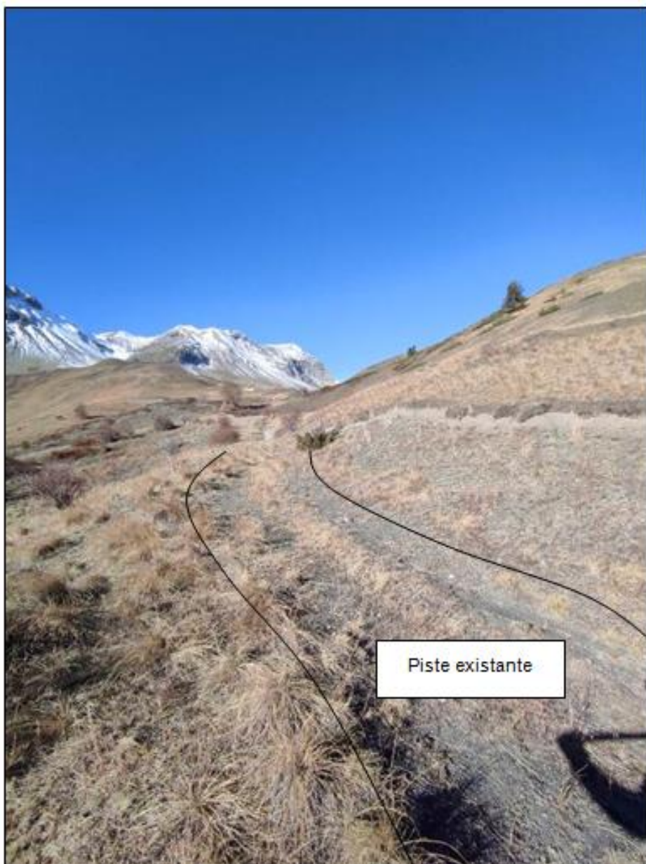
Figure 6 : tracé de la conduite d'adduction sous la piste existante (en lieu et place de la conduite actuelle) (19/11/2020)
