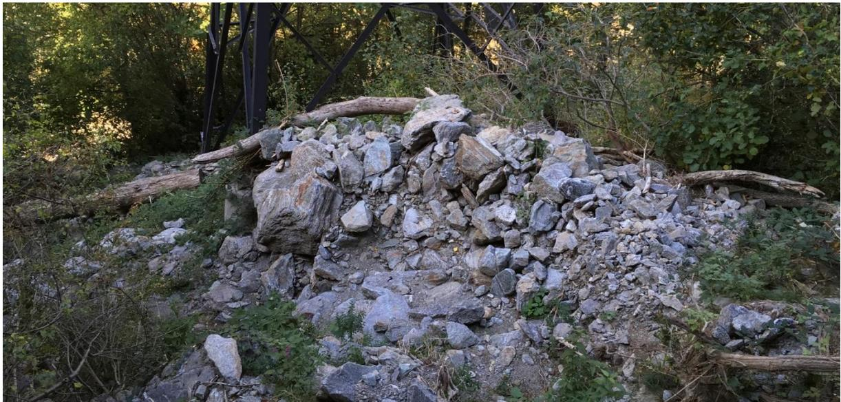
Photos 1 à 3 : la plateforme du pylône 46 dans son état actuel après le violent orage qui a eu lieu courant juin. Les fortes pluies ont fait gonfler le torrent « à sec aujourd'hui » qui a remodelé la plateforme. Le lit du torrent a été creusé localement de deux mètres et plus d'un mètre de matériaux (rochers et troncs d'arbres) se sont amoncelés contre les pieds du support. Dans ces conditions toute présence de Spélerpès est à exclure ici. Photos prises le 04 octobre 2017.
