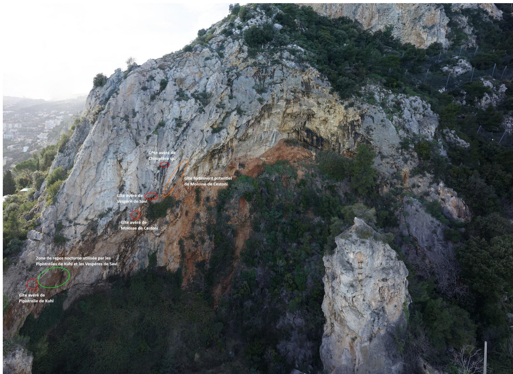
Gîtes mis en évidence/confirmés lors du passage du 29-31 mai 2018
