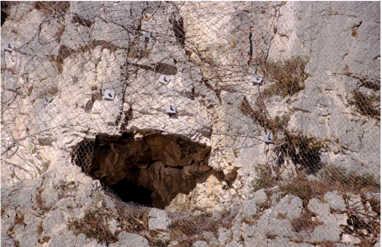
Photo : Exemple d'ouverture dans un grillage au niveau de l'entrée d'un gîte
