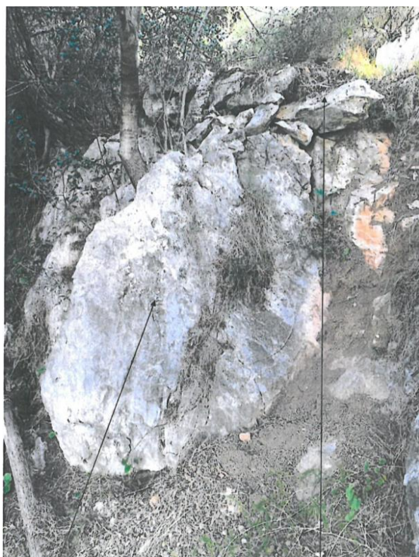
Bloc à conforter par clouage ou canevas de câble Blocs très fracturés à purger ou stabiliser
