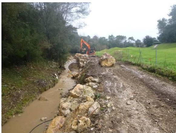
**Mise en place des rochers à partir d'une pelleteuse positionnée sur la berge**
