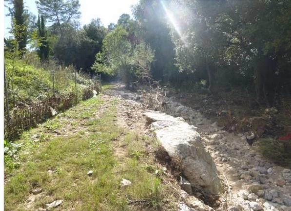
**Erosion notable d'une berge non renforcée lors des travaux de début 2015 en raison de la présence de Consoude bulbeuse**
